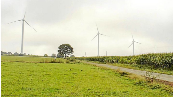
La commune compte déjà 4 éoliennes mises en service en août 2005. Mais qu'un nouveau projet s'annonce, il n'en faut pas plus pour créer le débat entre les pros et les anti-éoliens.
